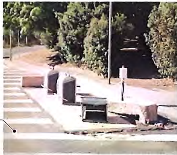
L'isola ecologica danneggiata e mai entrata in funzione
