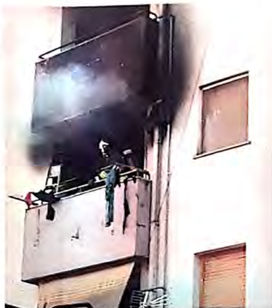
L'appartamento in cui si è sviluppato il rogo che ha creato danni strutturali
